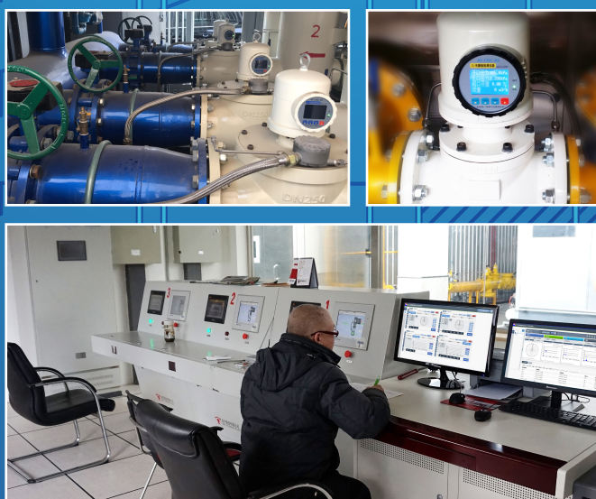
北京理工大学智能调压箱
